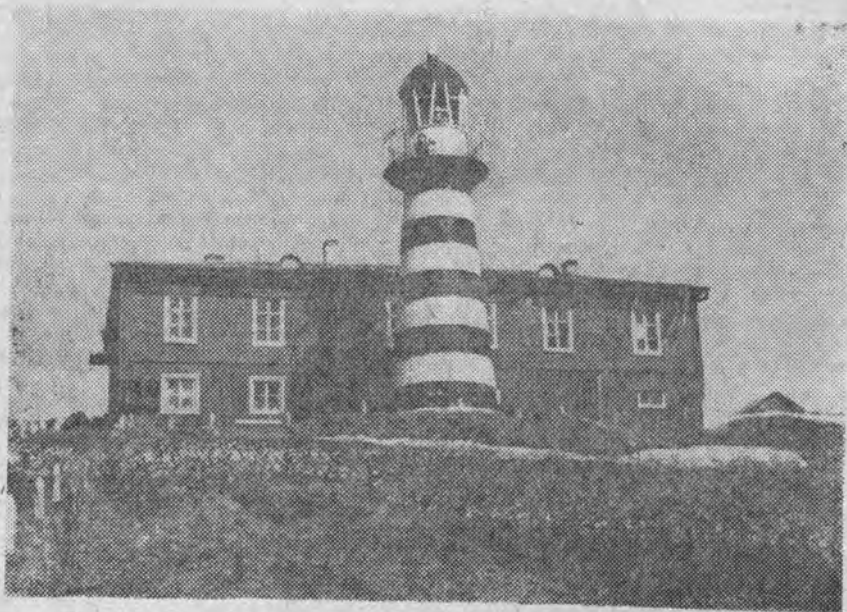
Рис. 1. Маяк Петропавловский, вид со стороны океана, 1965 г.
