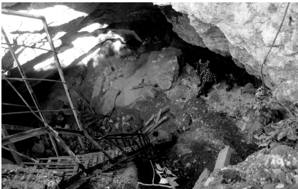
Рис. 2. Восстановление лестницы на входе в пещеру Голубинский Провал, смещенной при обвале горных пород в июле 2012 года.
