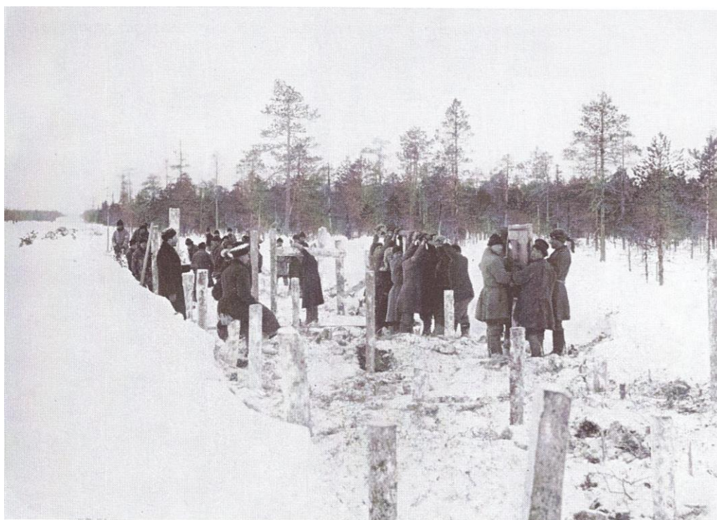
Рис. 1. Забивка свай ручными бабами при устройстве временной дороги по глубокому болоту, зима 1894-1895 года. Фото П.Ю. Майера.
