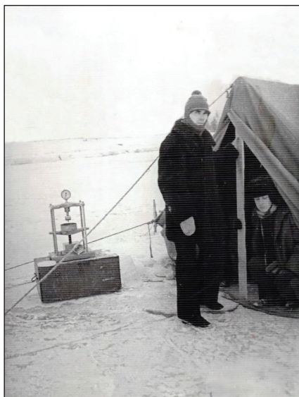
Рис. 111. Полевая испытательная машина ПИМ-100. Подготовка к работе (фото из архива автора).
