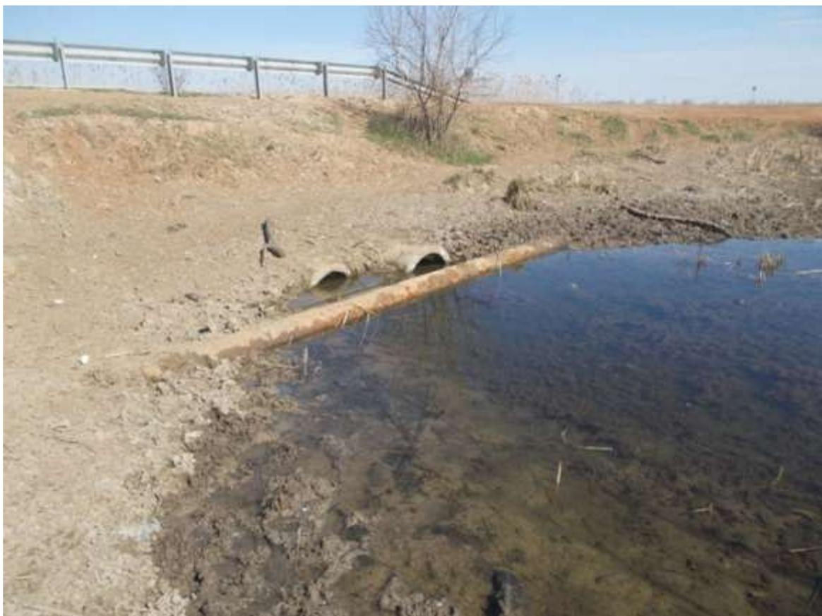
**Рис. 13. Земляная насыпь, перекрывающая пропуск паводковых вод в ильмень (фото Андросова В.П.).**
