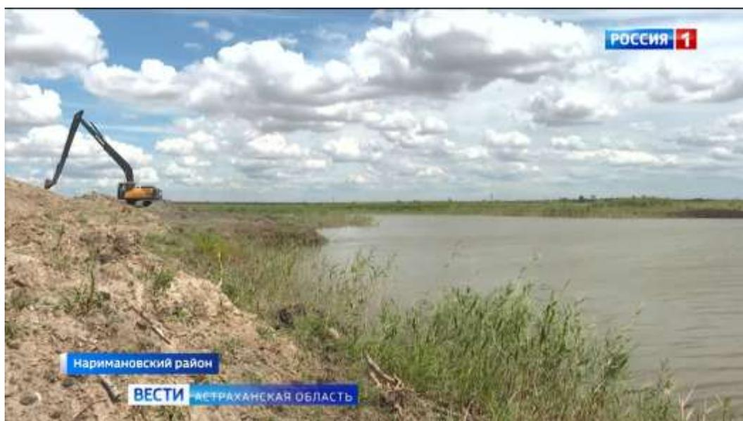
**Рис. 15.** На ильмене работают экскаваторы, а фуры одна за другой увозят грунт, поднятый со дна. Местами глубина уже достигает до 3,5 метров.
