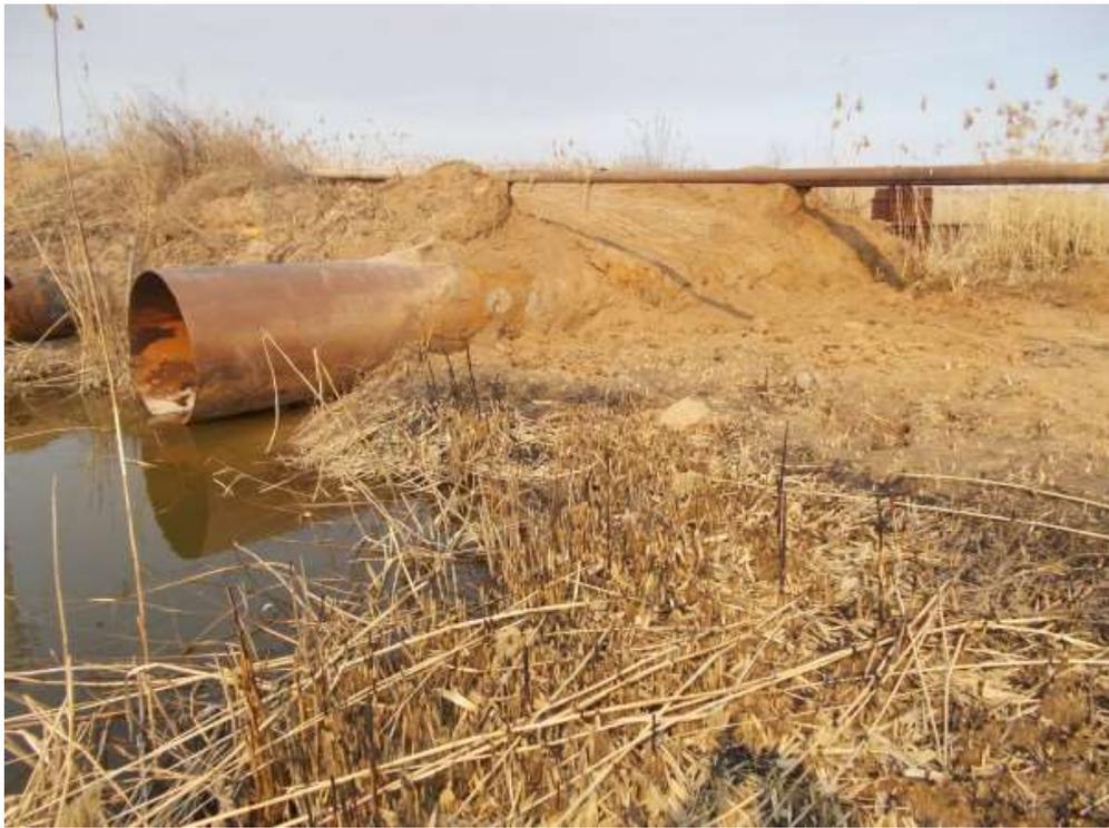
**Рис. 6. Со стороны захода воды оставлен и камыш, и бровка земли, которая на метр выше воды. Фото Андросова В.П.**
