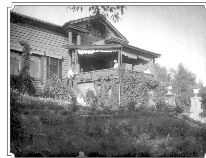
Дом А.Н. Островского, южный фасад. Конец XIX века.
