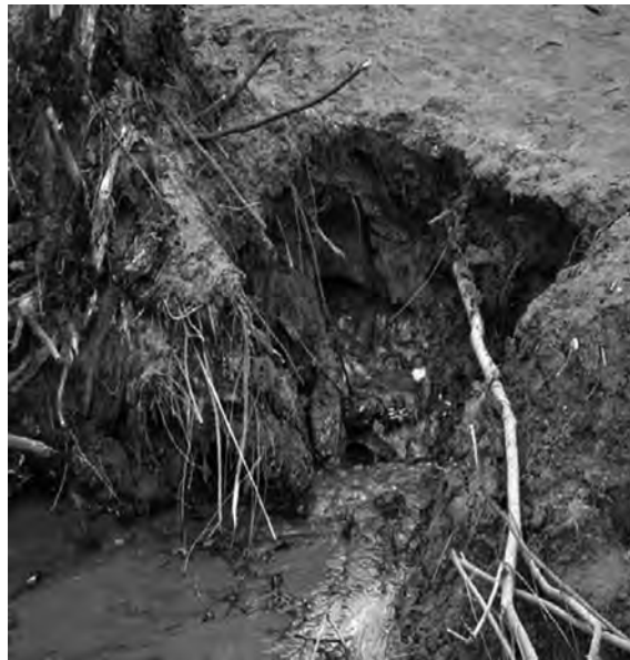
Рис. 3.8. Фильтрация воды через тело дамбы.
