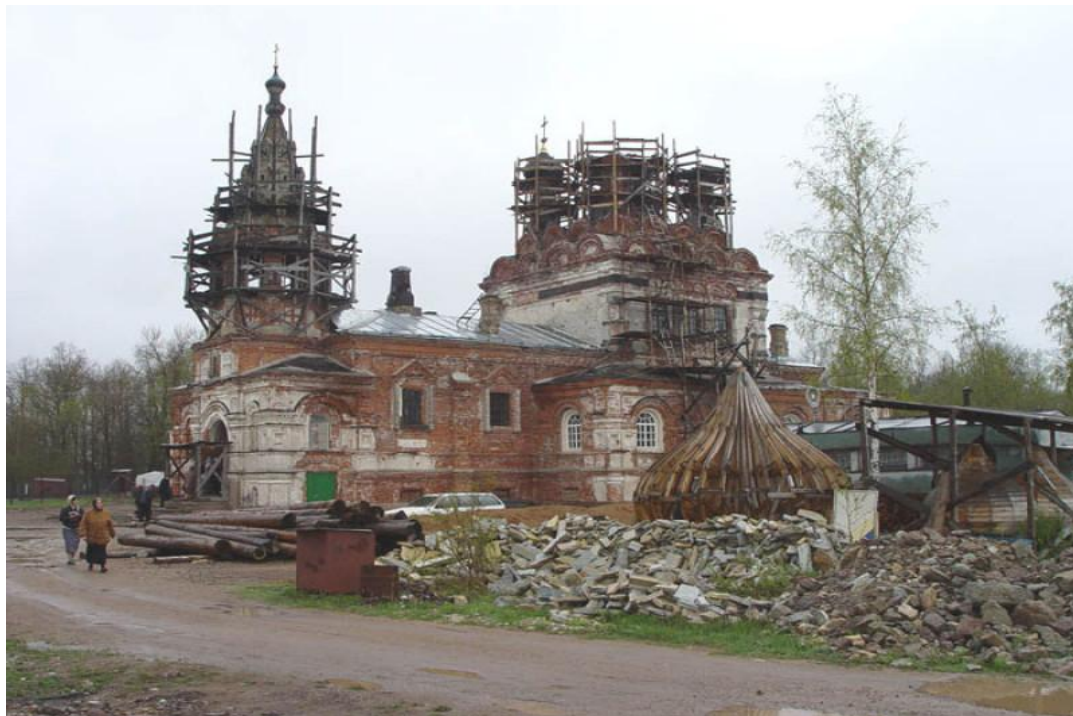
(рис. 13) церковь перед реставрацией
