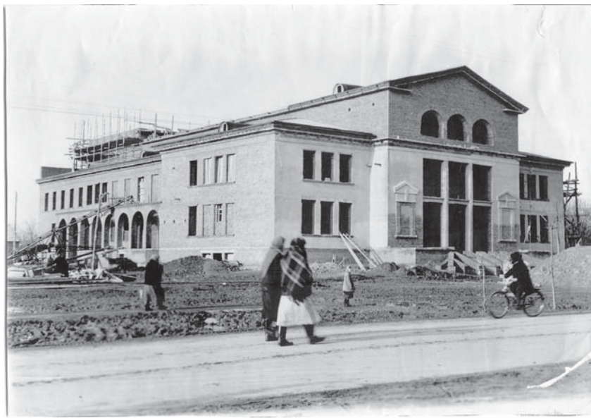
Рис. 1. Строительство районного Дома культуры. Январь 1958 года
