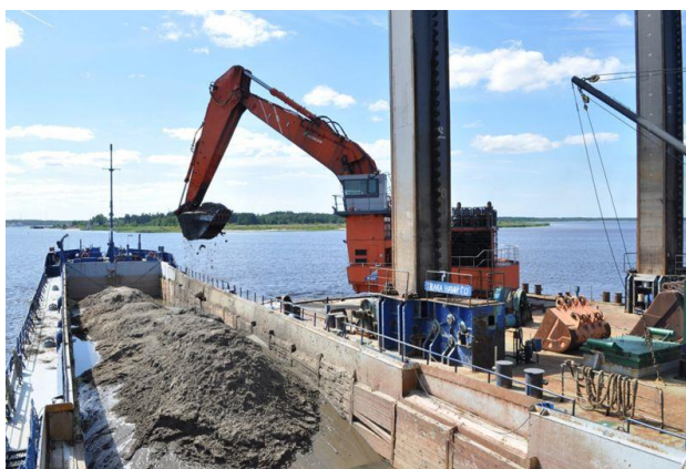
Рисунок 2 - Подача извлеченного грунта штанговым землечерпательным снарядом в грунтоотвозную шаланду.
