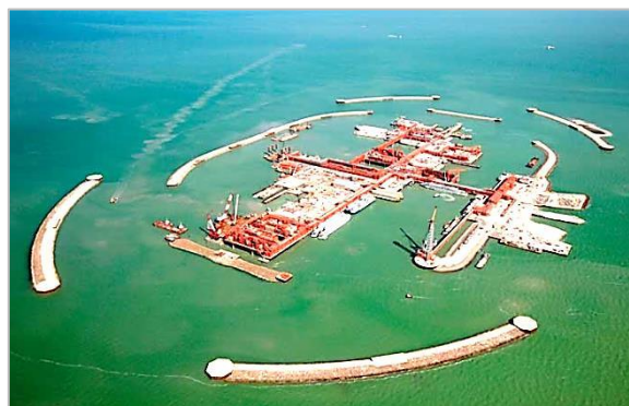
Ледозащитные сооружения на морском месторождении «Кашаган» (фото из интернета)
