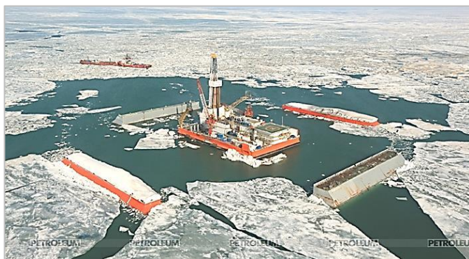
Ледозащитные сооружения на морском месторождении «Кашаган» (фото из интернета)
