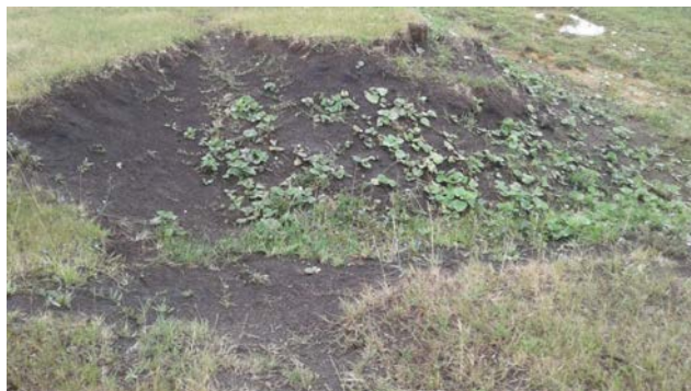
Рис. 2. Эрозионная борозда (фото И. В. Шапошникова )
