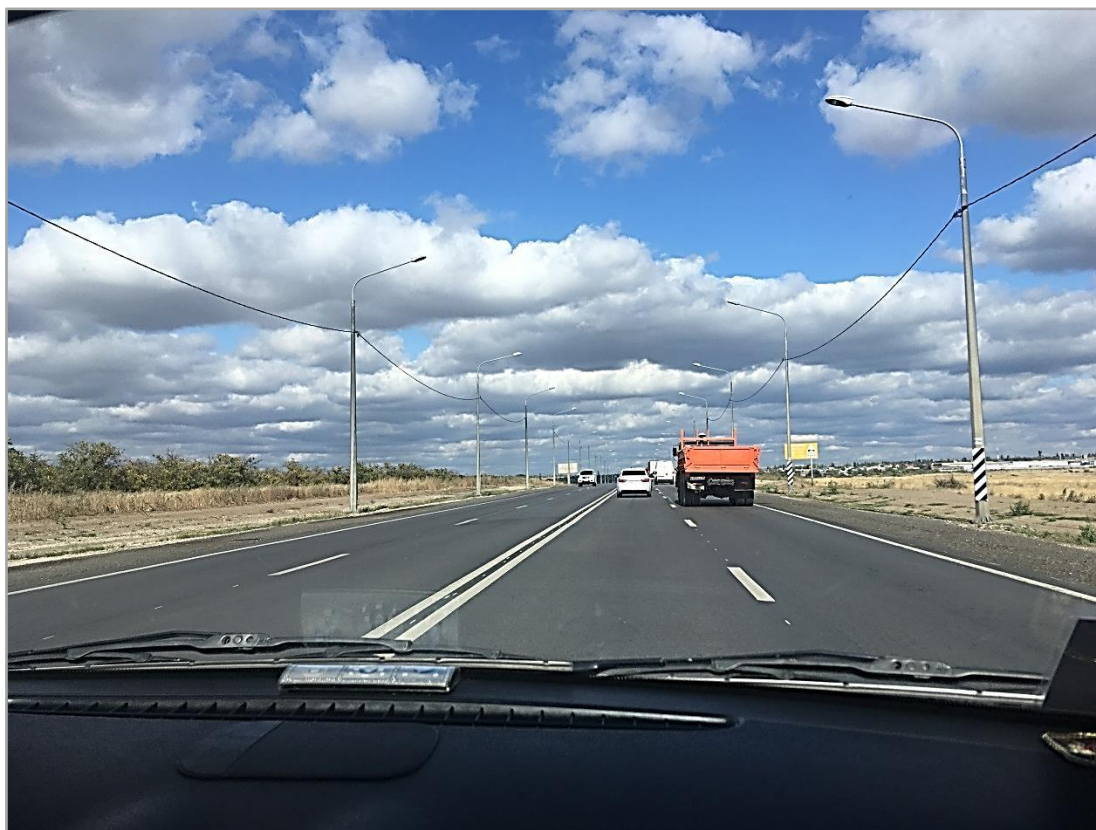
Участок дороги между Черным Яром и Волгоградом
