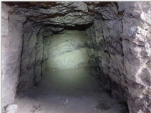
Рис. 9. Вид внутри выработки. Фото И.В. Головачева
