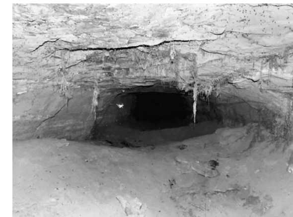
Рис. 10. Подземное сооружение «Молдавское-1». Восточный участок потерны
