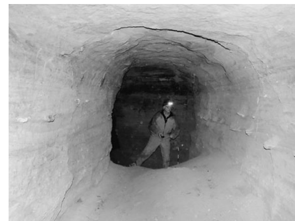
Рис. 9. Подземное сооружение «Молдавское-1». Западный участок потерны, вид на сбойку
