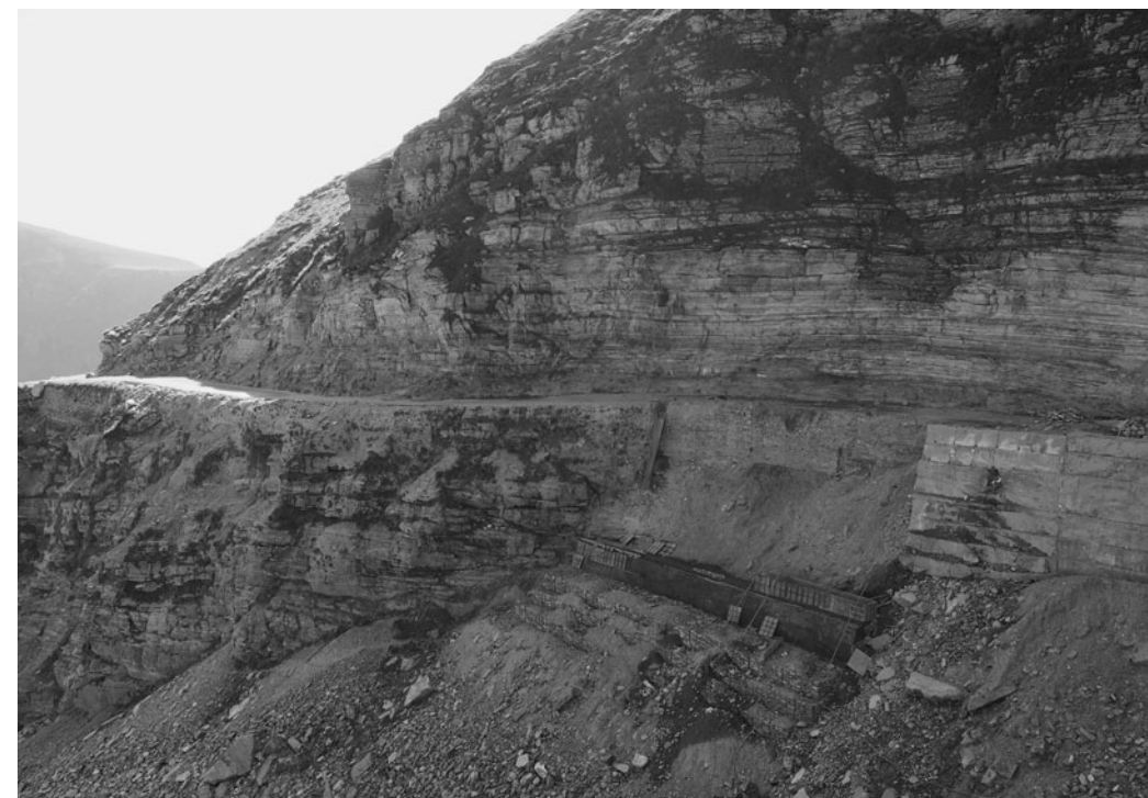
Рис. 3. Узкая лента стратегической автомобильной дороги из долины часто прерывается обвалами и оползнями
