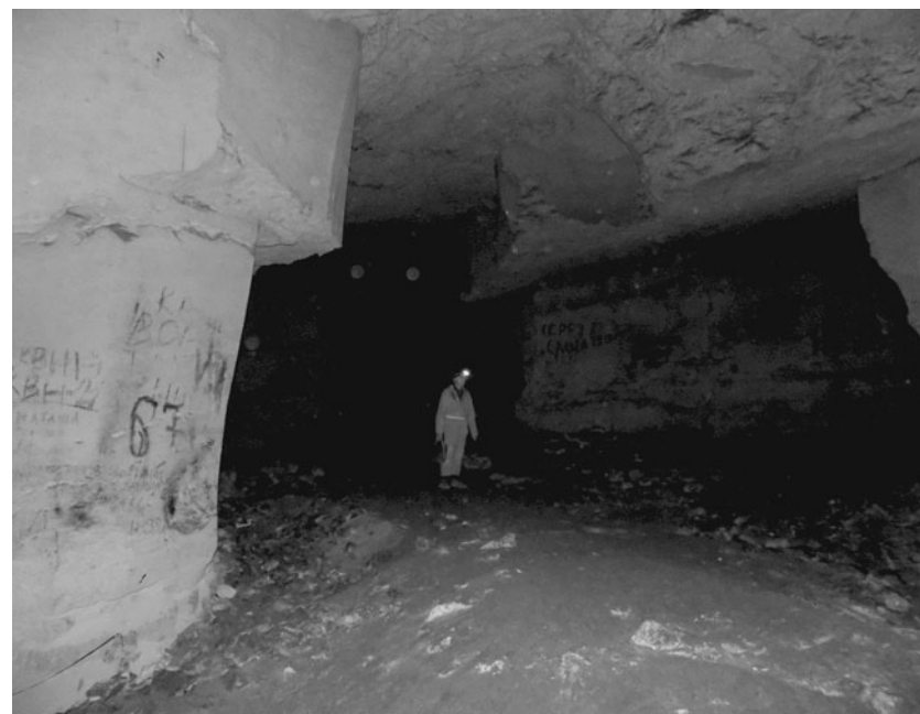
Рис. 8. Центральная часть нижней выработки. Фрагмент насыпи узкоколейного рельсового пути
