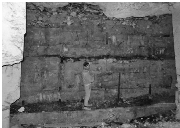
Рис. 11. Нижняя выработка. Бетонное перекрытие одного из проходов
