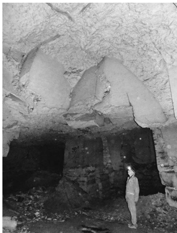
Рис. 12. Нижняя выработка. Интересные куполообразные выпилы в кровле
