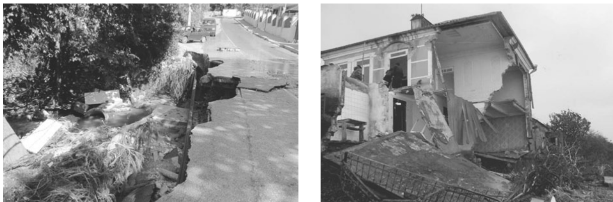
Рис. 4. Примеры разрушения прибрежной инфраструктуры: разрушение дорог, разрушение домов
